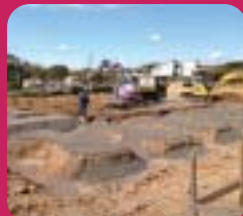
基礎工事が始まりました。 —— 飛鳥 ——
